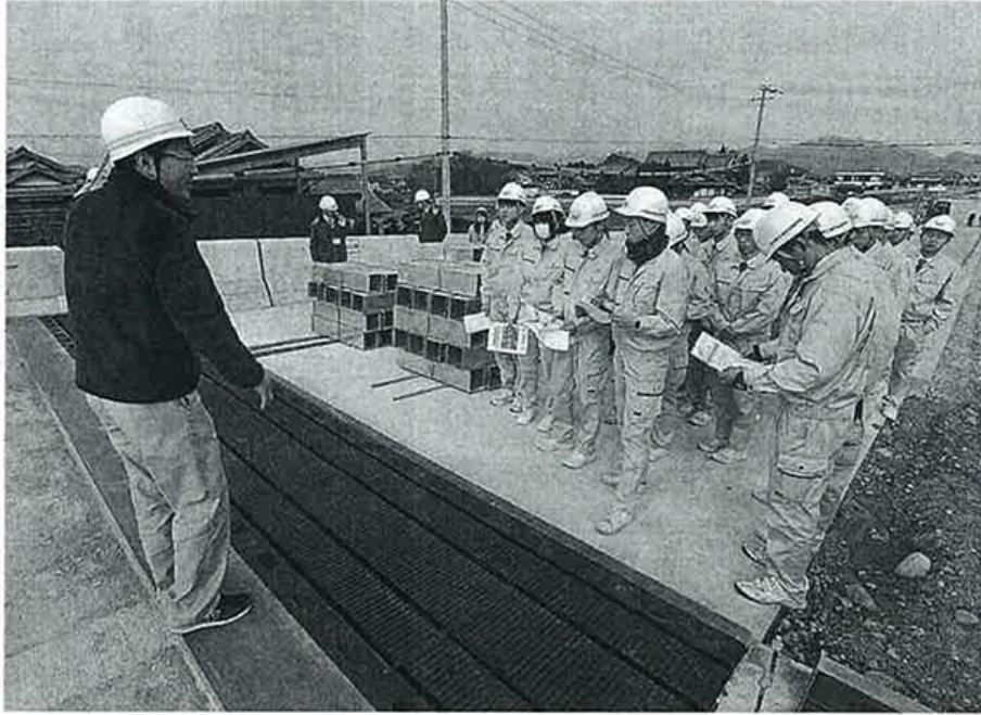
3月末の供用開始に向けて大詰めが行われている「令和跨線橋」の現場を見学＝いずれも、たつの市揖保町東用
